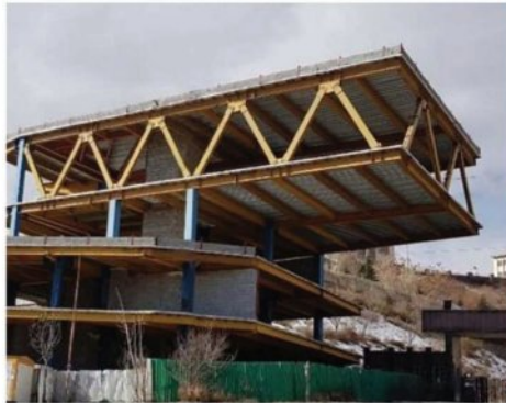
▲ دماوند: نمونه کنسول کار شده به طول ۱۲ متر
