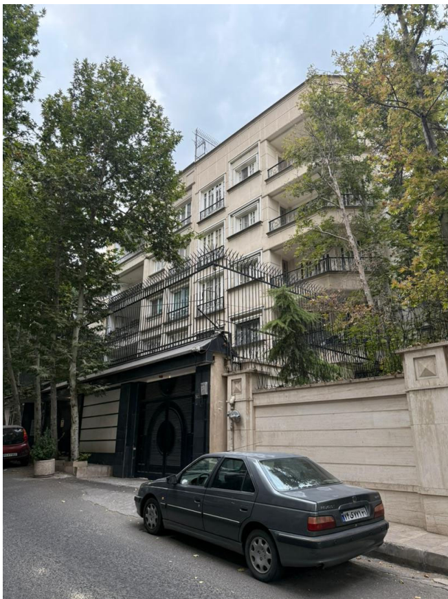
ساختمان شماره ۱۴ و ۱۵ ۴ طبقه روی همکف
