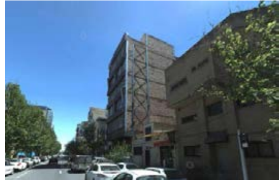
تصویر ۶۸- بی‌توجهی به نمای جانبی در ساختمان نوسازی شده با ارتفاع بلندتر نسبت به ساختمان همسایه، محله سپهر
