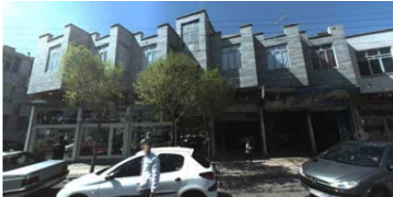
تصویر ۵۶ - کنسول کردن حجم ساختمان به صورت شکسته و ریتمیک، محله خانی‌آباد نو، خیابان میعاد
