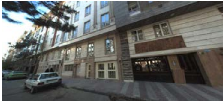
تصویر ۵۵ - هماهنگی در خط کنسول در نماهای مسکونی، محله تهرانپارس
