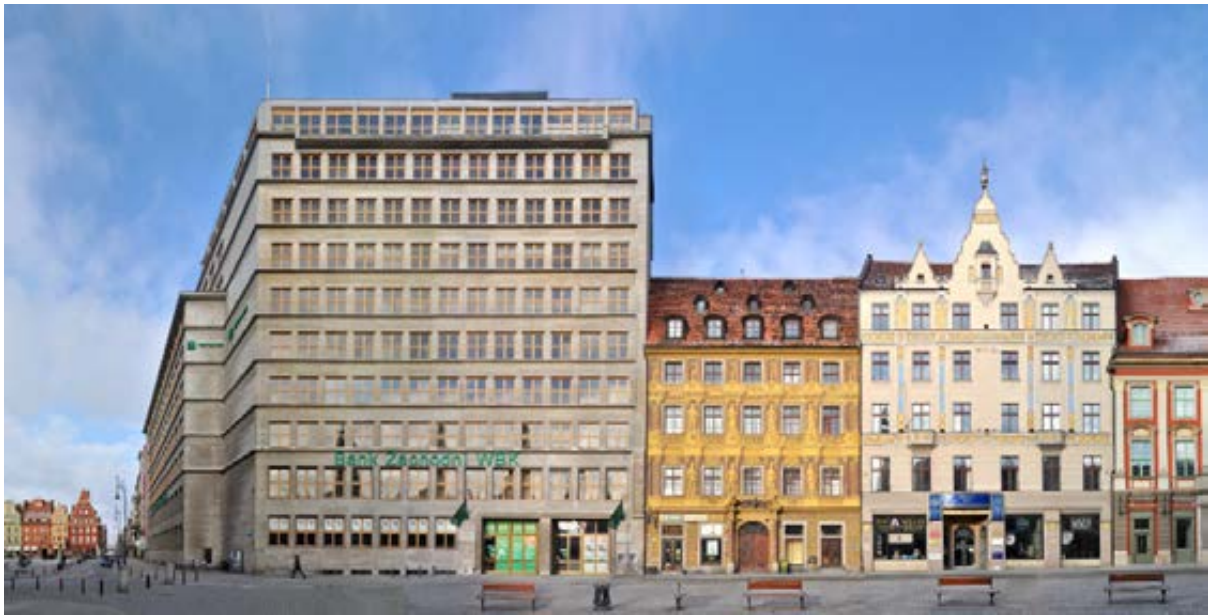
تصویر ۶۷ - عدم توجه به قطعه‌بندی و عرض ساختمان‌ها
