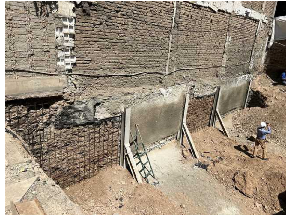
اجرای سازه نگهبان
