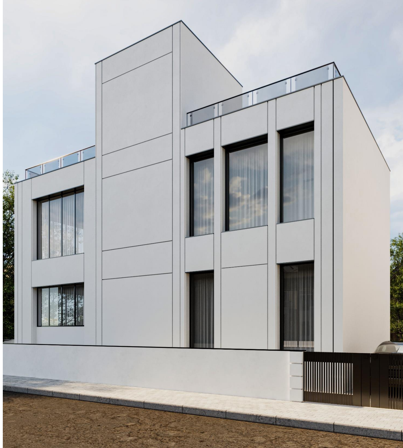
دید به نمای جنوبی و شرقی (جاگذاری ماشین در سمت جنوب شرقی پروژه)
