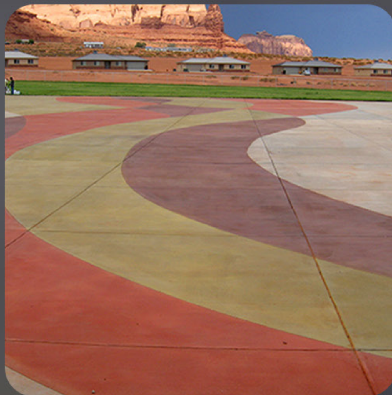
● بتن رنگی در کف
