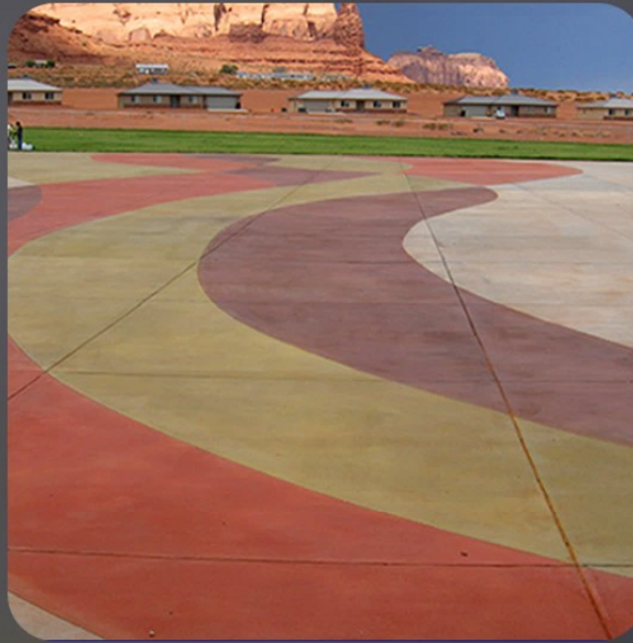
● بتن رنگی در کف
